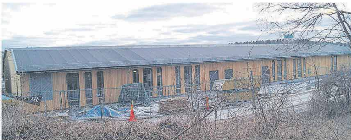
Slutbesiktningen av nya sporthallen skjuts fram cirka fem veckor.
