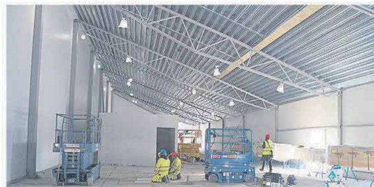
Sporthallen kommer att ha flyttbara läktare, en långsgående balkong ovanför träningsytorna. På bilden ses utrymmet för blivande omklädningsrum.
