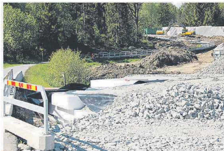
Påfarten till förbifartsbygget byggs på stora vita frigolitblock eftersom marken på platsen är för sank för att bygga rakt på. FOTO: LO BÄCKLINDER
