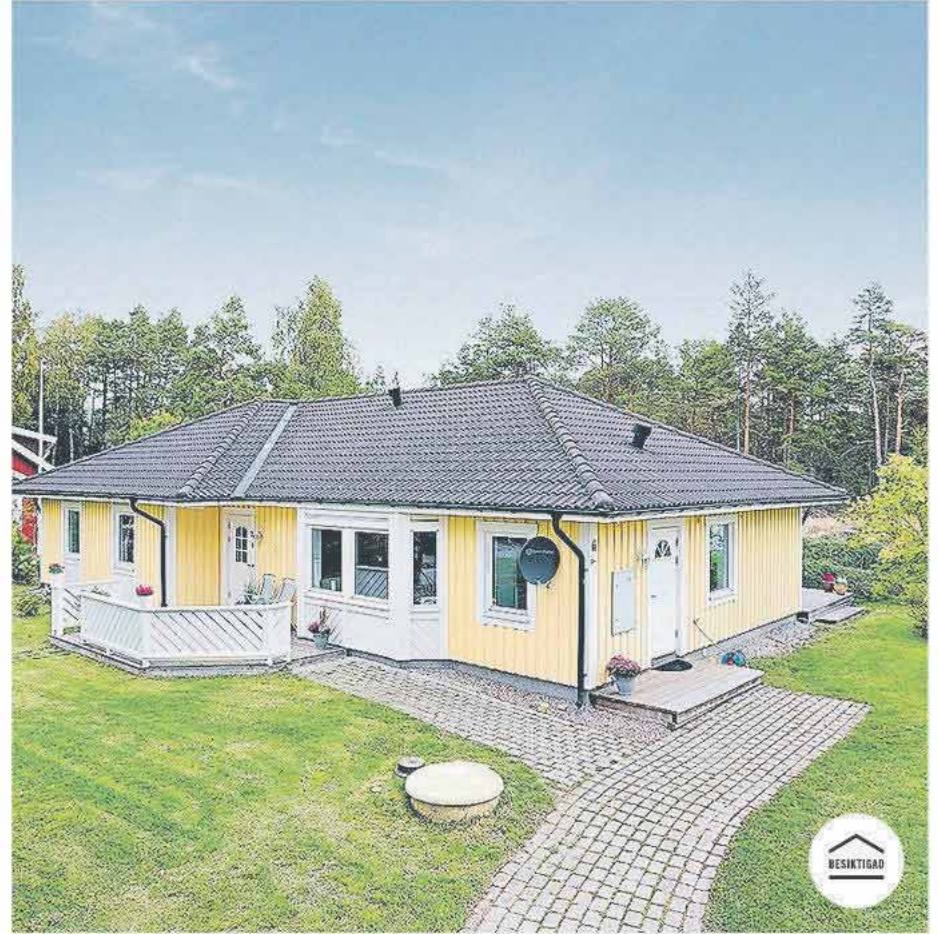
Färingsö Stenhamra | Klyvarestigen 34B
