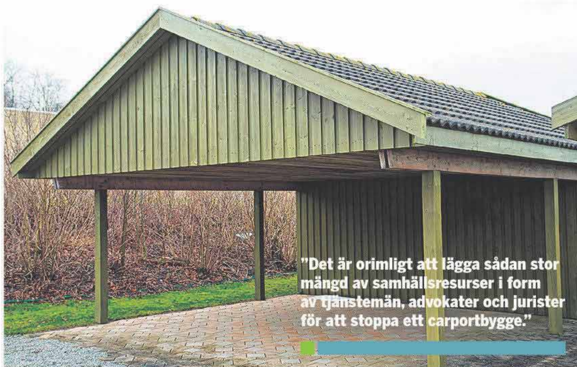
Bygglov för en Carport avslags flera gånger av kommunen. Carporten på bilden är inte den artikeln tar upp. FOTO: ARKIV
