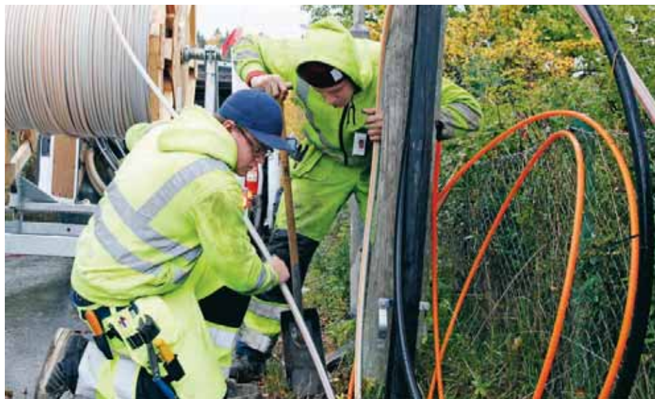
Under det gångna året har en febril verksamhet pågått runt om på Mälaröarna när fiberkablar har dragits fram. Foto: Ove Westerberg
