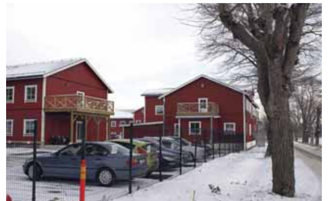
Tre nybyggda, rödfärgade "lador" med plats för lokalt företagande. Här sett från Ekebyhovsallén. Foto: Ewa Linnros
