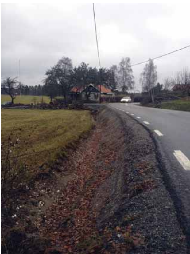
Längs med väg 802 på Färingsö har djupa diken grävts. Vägen är redan smal och den branta kanten ner i diket, gör det svårt att hålla åt sidan vid möte av exempelvis en buss. Foto: Ewa Linnros
