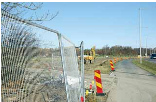
På Lovön har förberedelserna påbörjats för att flytta ledningar, dra om cykelbanor och anlägga de blivande arbetsplatserna.
