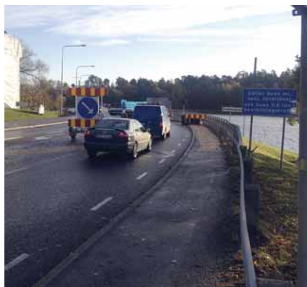
Ett körfält är avstängt på Drottningholmsbron på grund av arbete med att byta ut brofogarna. Första etappen av arbetet beräknas pågå fram till mitten av december.
