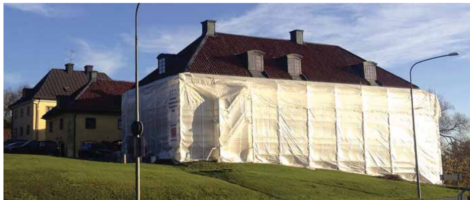
Fasaden på Hertigarnas stall genomgår en grundlig renovering. Bland annat kommer byggnaden att återfå sin ursprungliga färg som är samma som bland annat Drottningholms slott. Foto: Ewa Linnros
