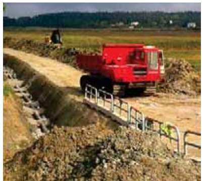
VA-grävning från Svartsjö slott och norrut.
