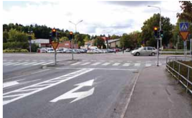
Nya pilar gjorde att bilar som skulle rakt fram hamnade i samma fil som de som skulle till höger. Men trafiksignalerna visade olika för de bägge köralternativen. Resultat: De svängande bilarna kunde inte köra om framförvarande skulle rakt fram. Foto: Ewa Linnros
