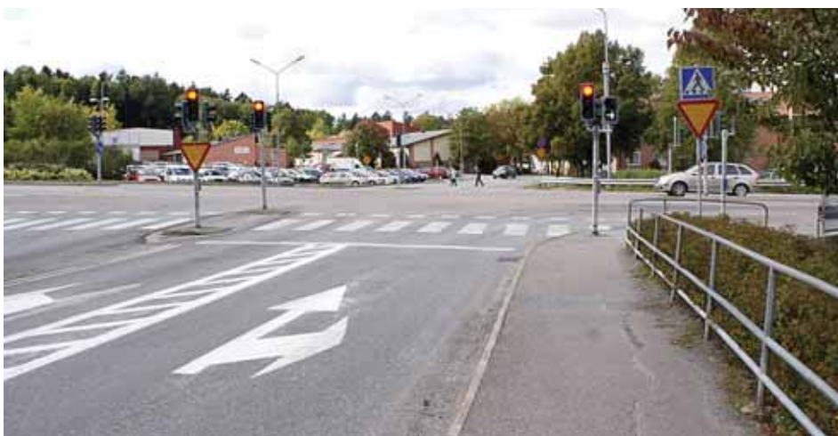
Felmålade vägmarkeringar vållade problem.
