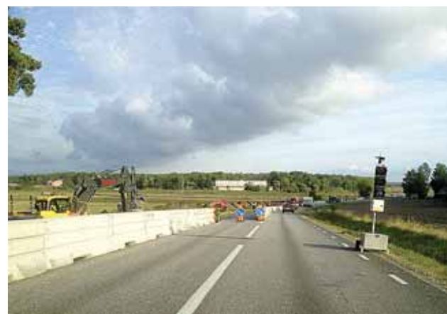
De VA-arbeten som pågår mellan Svartsjö och Vifärna/Korslöt skapar hinder i trafiken med avstängda vägbanor och trafikljus.
