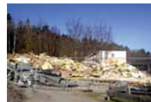
Resterna av paviljongen intill infartsparkeringen i Träkvista.
