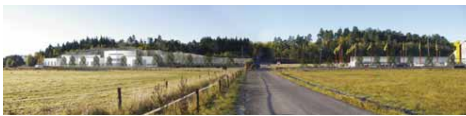
Bussdepån sedd från Troxhammar byväg mot korsningen Enlundavägen/Färentunavägen.
