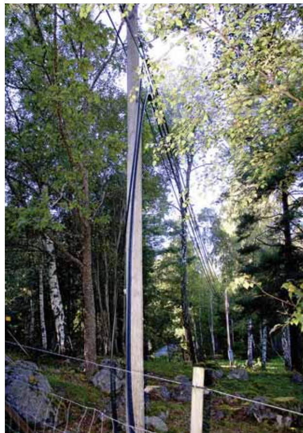
På Adelsö har dragningen av fiberkabel redan påbörjats. Vissa sträckor följer nätet de befintliga luftledningarna. Foto: Lo Bäcklinder
