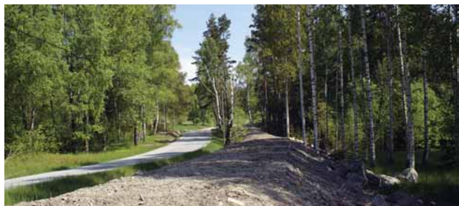
Längs Jungfrusundsvägen har arbetet med en cykelväg påbörjats.
