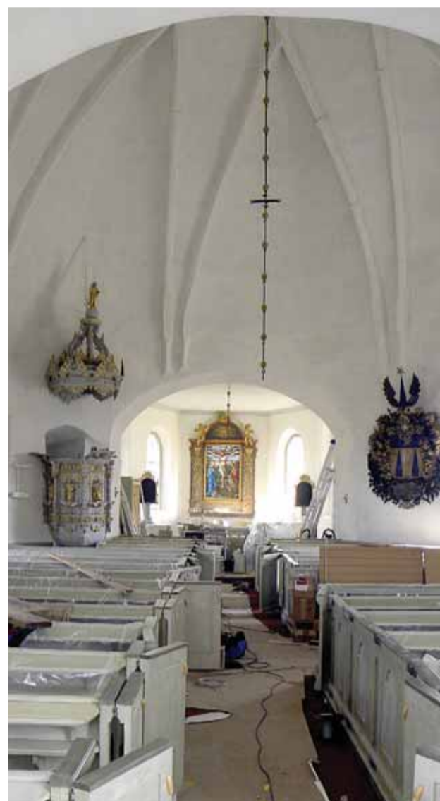
Munsö kyrka Sedan första advent har Munsö kyrka varit stängd för renovering men nu är arbetet inne i slutfasen och i pingst släpps åter kyrkobesökarna in i en av landets få runda kyrkor.
