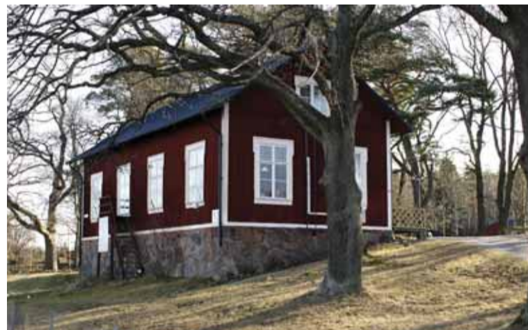
Gamla Ekebyhovsskolan står fortfarande kvar. Idag sker dock ingen undervisning i byggnaden. Sedan ett par år tillbaka drivs här en secondhand-butik. Foto: Ewa Linnros
