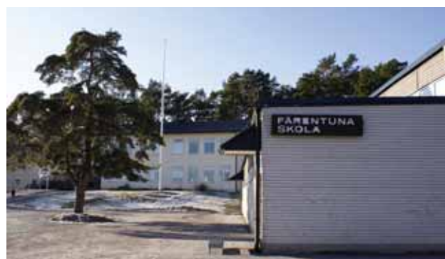
Färentuna skola har stort behov av renovering. I nära tio års tid har det planerats för åtgärder men ännu har inget beslut fattats.
