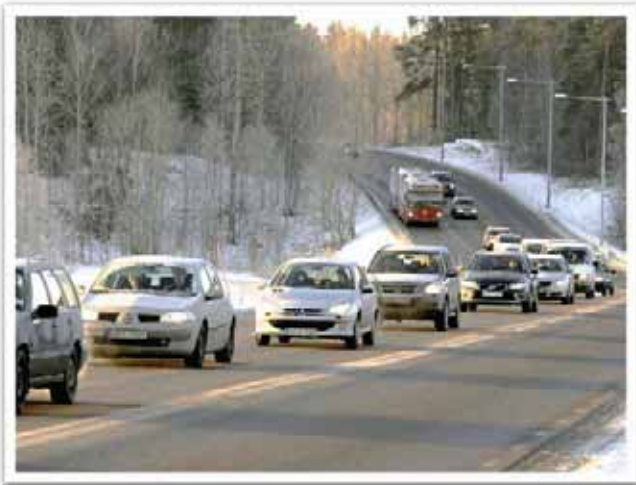
Breddning av Ekerövägen
