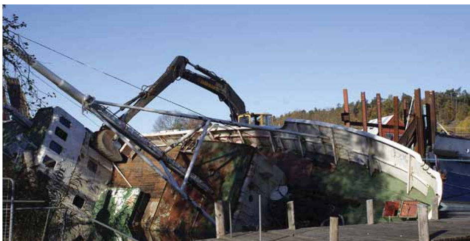
Tugab construction anlätades av Seasides ägare för att bärga Seaside. De startade också upp arbetet vid Seaside, något som strider mot det avtal som kronofogdemyndigheten skrivit med Pampas marina och Marin & haverikonsult KA AB. På bilden ses Tugabs grävsropa böjd över Seaside. Foto: Ewa Linnros
