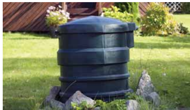
Det så kallade LTA-systemet är ett lågtrycksavloppssystem, där varje fastighet har en egen pump. En lagändring gjordes 2007 i vattentjänst- lagen. Detta medförde att kommunerna övertog ansvaret för pumparna. Det råder däremot oklarheter kring vem som ska bära ansvaret för pumpar som är installerade före lagändringen. Foto: Ewa Linnros
