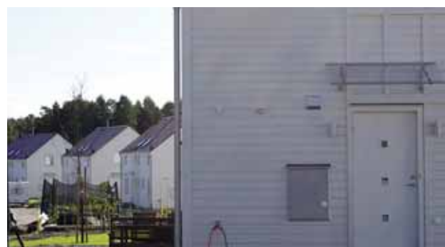
De sju fastigheter på Småsvaltingens väg i Sandudden som Finn-domo hem har uppfört, är ännu inte färdigställda. Detta trots att slutleverensdatum för länge sedan passerat och inflyttning har skett.
