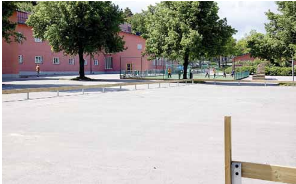
De nya parkeringsplatserna som redan börjat anläggas är belägna intill konstgräsplanen på Tappströmsskolans gård och kommer även att gränsa till den planerade volleybollplanen. Foto: Lo Bäcklinder
