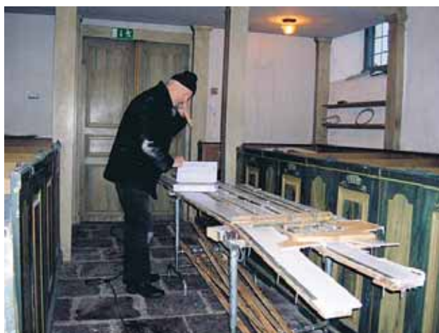
Slottsarkitekt Erik Langlet kontrollerar pågående arbete i Adelsö kyrka. Man förbereder bland annat för ny dragnings av ledningar för el, ljus och ljud. Foto: Solveig Magnusson
