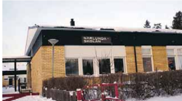
Mögelskador har även påträffats på Närlundaskolan. Nu ska hela skolan fuktmätas. Foto: Ewa Linnros
