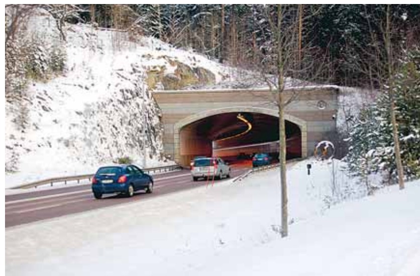
Polisen varnar för att det kan vara halt även där man tror att väglaget är bra. Infarten till Lindö tunnel är ett sådant exempel.
