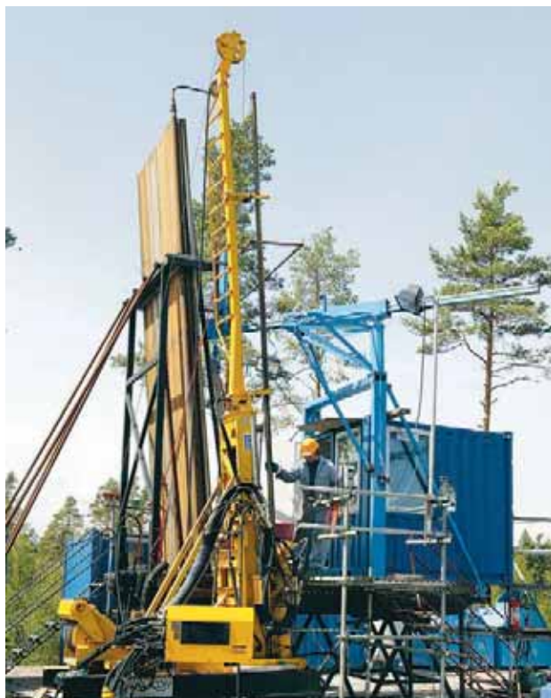
Borrmaskin med tillhörande styrhytt och generator som används vid så kallad styrd kärnboring. Foto: Curt-Robert Lindqvist, källa SKB
