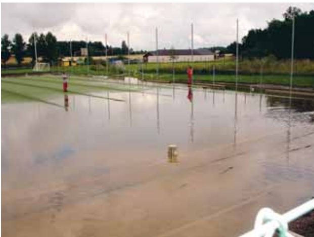
Svanängens IP översvämmades av stora regnmängder och invigningen av konstgräsplanen fick skjutas upp.
