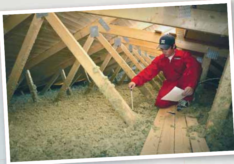
Tilläggsisolering av vinden – bästa tänkbara isoleringsmetod!
