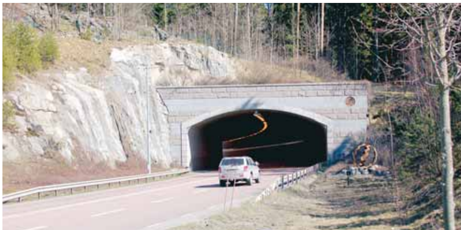
Kommunen och Trafikverket har enats om hur kostnaderna för breddningen av Lindö tunnel ska fördelas.
