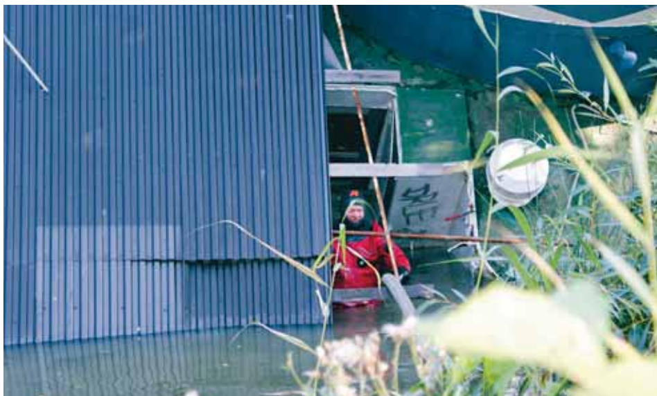
Dykare Tomas Andersson tar sig in i Sea Side för att förbereda slamsugning av Sea Side. Slamsugningen ägde rum måndagen den 5 oktober.
