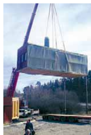
Sista modulen lyfts på plats
