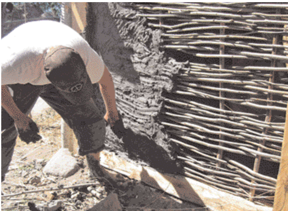
Anders Mordin isolerar husfasaden med havslera och sand.
