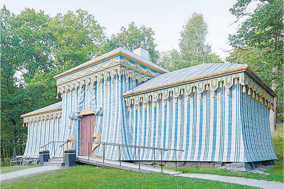
Vakttältet är byggt i trä, men framsidan och sidorna är klädda i linoljemålad bleckplåt. FOTO: SFV
