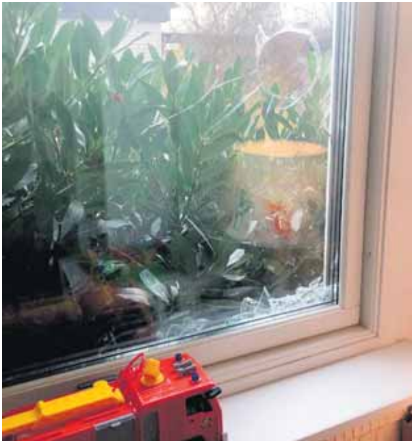
När Josefin drog upp rullgardinen upptäckte hon ett stort hål i fönstret. Nedanför på marken låg den stora stenen som någon kastat.
