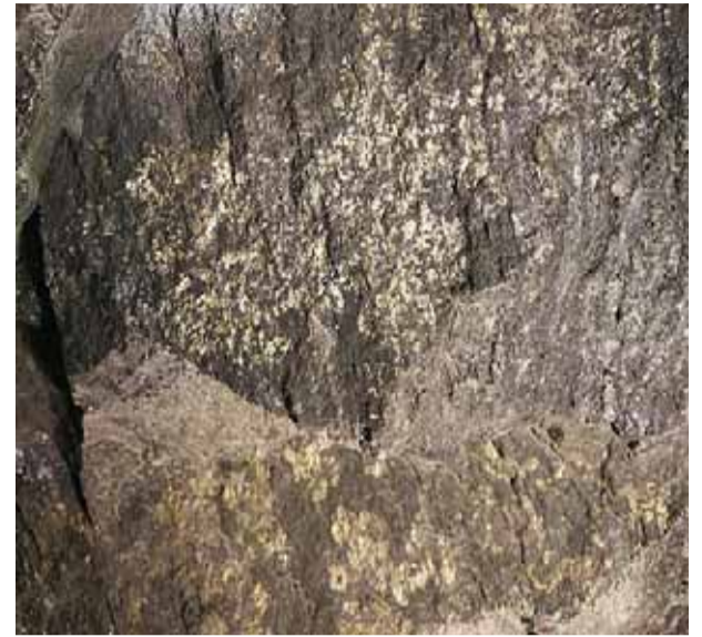
Så snart sprängmassorna forslats ut ur berget kommer geologerna in och undersöker bergväggarna för att avgöra hur de ska förstärkas (t.v.). Ibland möts de av ett guldskimrande tak (t.h) vilket är svavelkis.
