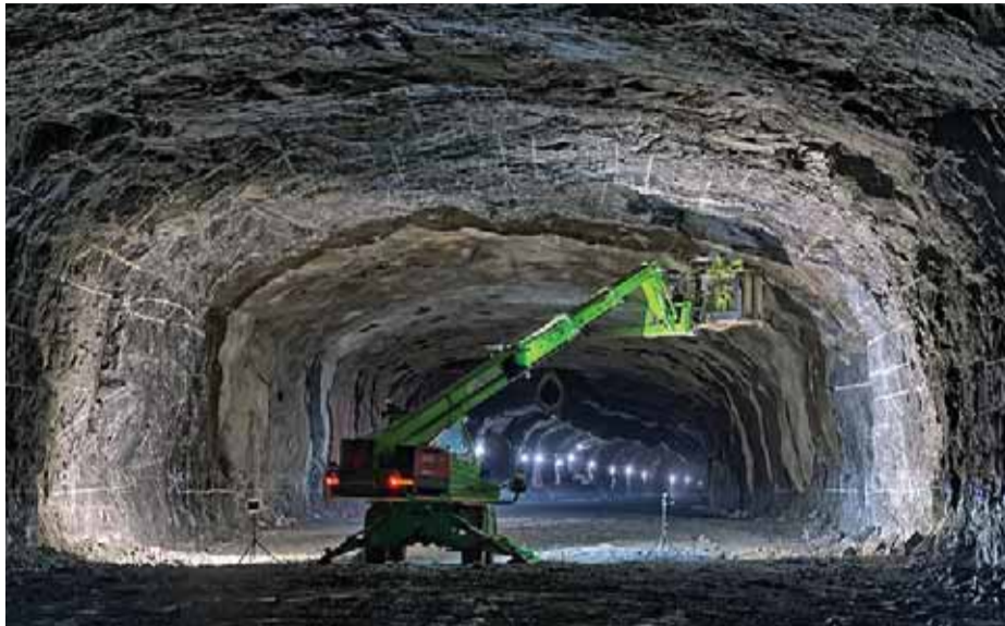
Så snart sprängmassorna forslats ut ur berget kommer geologerna in och undersöker bergväggarna för att avgöra hur de ska förstärkas (t.v.). Ibland möts de av ett guldskimrande tak (t.h) vilket är svavelkis.
