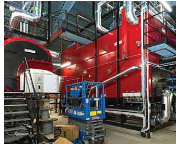
Det nya värmeverket i Bryggaområdet har två flispannorna som kommer eldas med biobränsle för att försöka kunderna på Ekerö med fjärrvärme.
