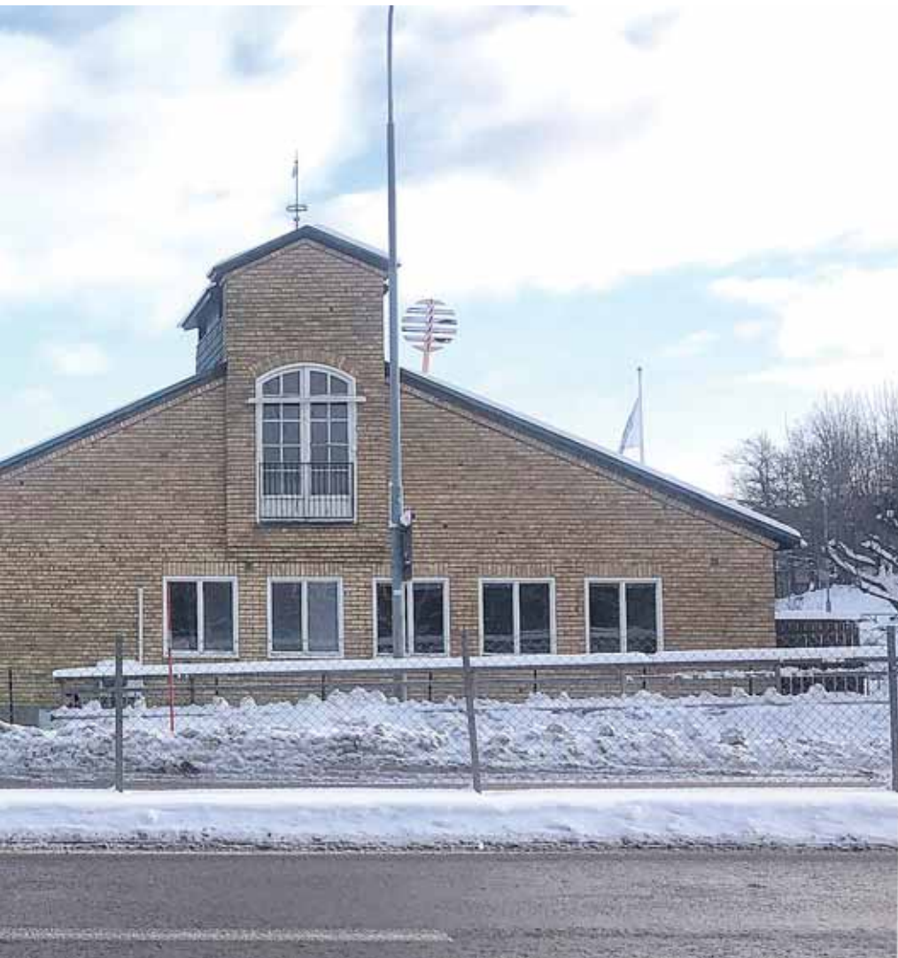
1940-tal och är byggt med tegel från tegelbruket som låg i Tappsund. Liberalerna har lagt förslag om att bygga centrum i Ekerö centrum. Han tycker det är en bra idé men att det också måste fungera med allt annat som ska byggas i centrum. FOTO: NAMN
