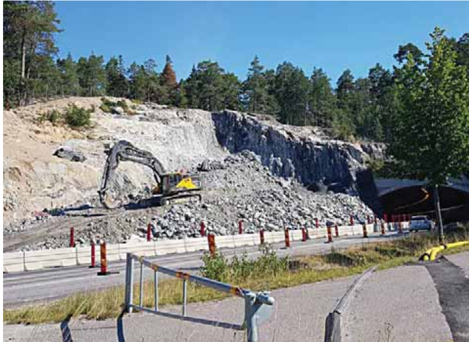
Vid Lindö tunnel pågår arbetet med att spränga bort berg för att komma ned till den nivå där det nya tunnelröret ska gå. FOTO: TRAFIKVERKET
