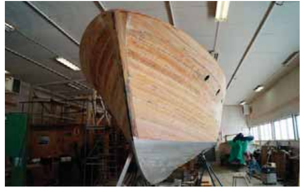
M/S Wasaholm 2020. Restaureringen är på god väg.
