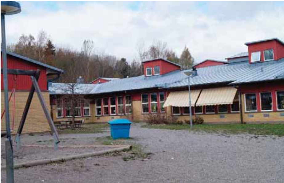
Platsen där den nuvarande Ekebyhovsskolan ligger, kan i framtiden nyttjas för en eventuell etablering av Internationella Engelska skolan (IES) samt en omlokalisering av Birkaskolan hit. FOTO: ARKIV
