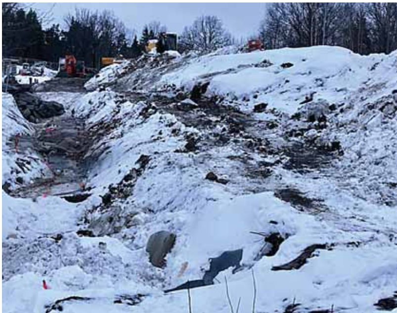
Det borras, sprängs och grävs i Stenhamra. Vad är det som är på gång? undrar en av läsarna.
