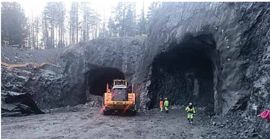
Tunnelmynningarna har fått sitt utseende och mäter nu tjugo meter in i berget.
