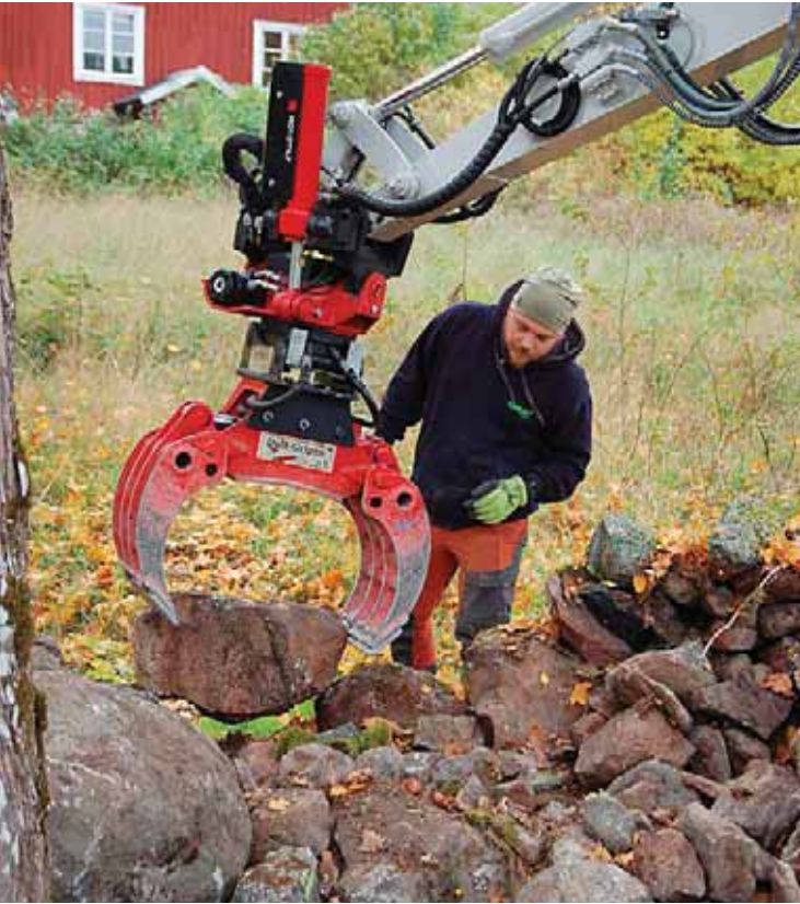
Att bygga upp den gamla muren är ett tidsödande arbete som kräver stor noggrannhet för att konstruktionen ska bli stabil. FOTO: LO BÄCKLINDER
