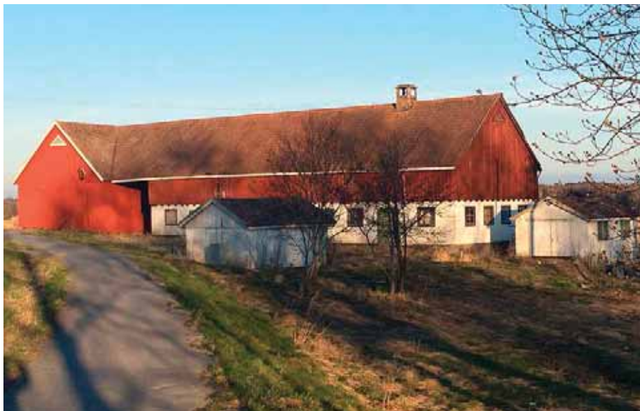
Ladan i Kungsberga by är från 1800-talet och utgör en "identitetsskapande byggnad" enligt en kulturmiljöanalys. Ladan är ett av de kulturarv som i detaljplanen föreslås att den ska rivas. FOTO: PRIVAT
