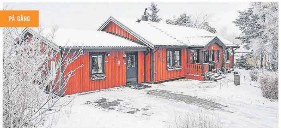
Ekerö | Färingsö Stenhamra Gudmundvägen 20
