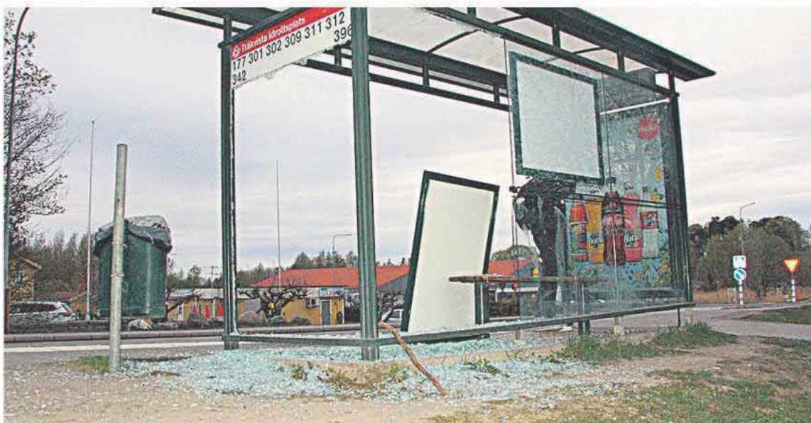
Förutom de stora kostnaderna, är de stora mängderna glas som ligger kring de vandaliserade busskurerna en fara för de människor som rör sig där. FOTO: LO BÄCKLINDER
