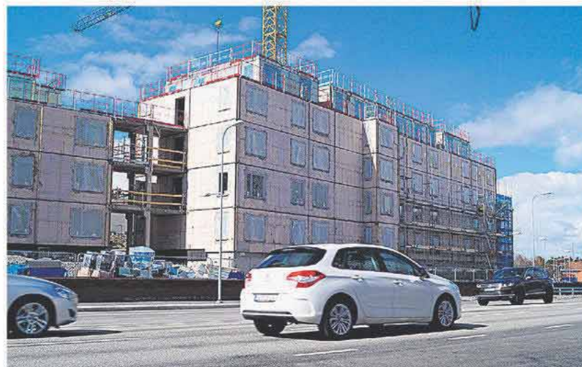
Klarar nybyggnationen vid Ekerövägen bullerkraven? Det frågar en läsare. Foto: Ewa Linnros
